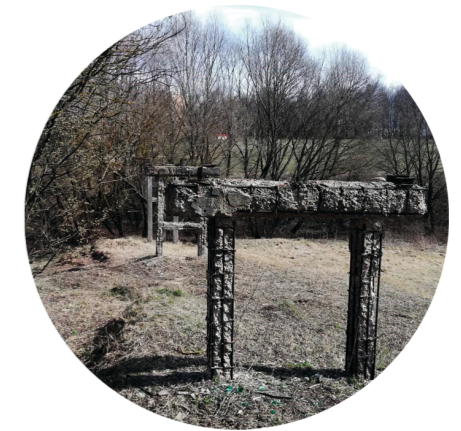
Старые бетонные конструкции для надземных коммуникаций
