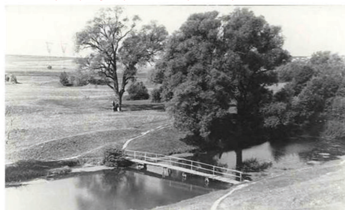
Мост через реку Тербенка, притока реки Лопасня.
